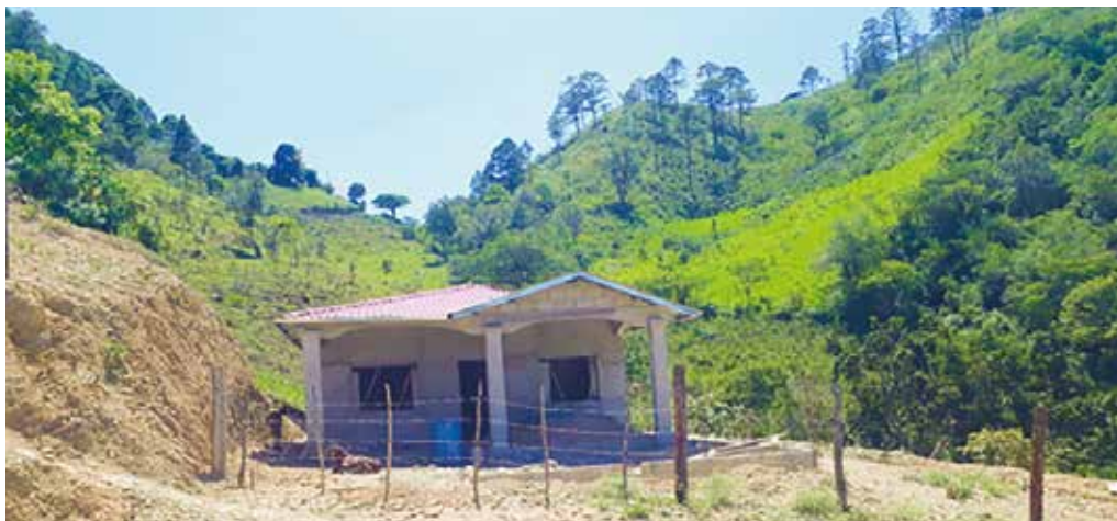
Imagen 6. Construcción de vivienda en la comunidad de Corral Falso. Parte de las remesas que se envían también son destinadas a las mejoras o construcción de nuevas viviendas con materiales más resistentes en relación con los que tradicionalmente se han venido utilizando (tierra, madera, zinc básico) y de diseños más complejos.
